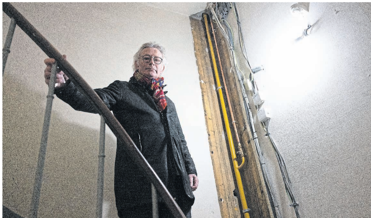
Paris (III e ), jeudi. « On a plein de vieux câbles qui débordent, certains sont abîmés, d'autres même plus coffrés », déplore Emmanuel de Poulpiquet, membre du conseil syndical de la copropriété de la rue de Sévigné.
