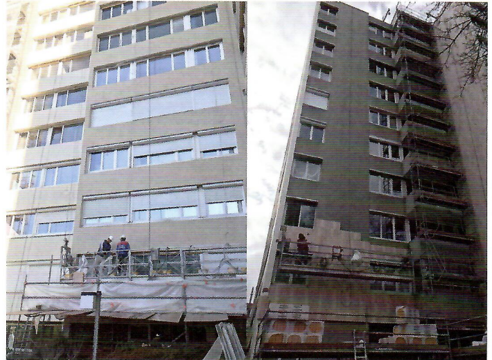
Résidence Rue du repos - Paris 20 e
